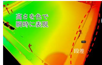
クラックで段差が生じている等の確認が容易に可能
